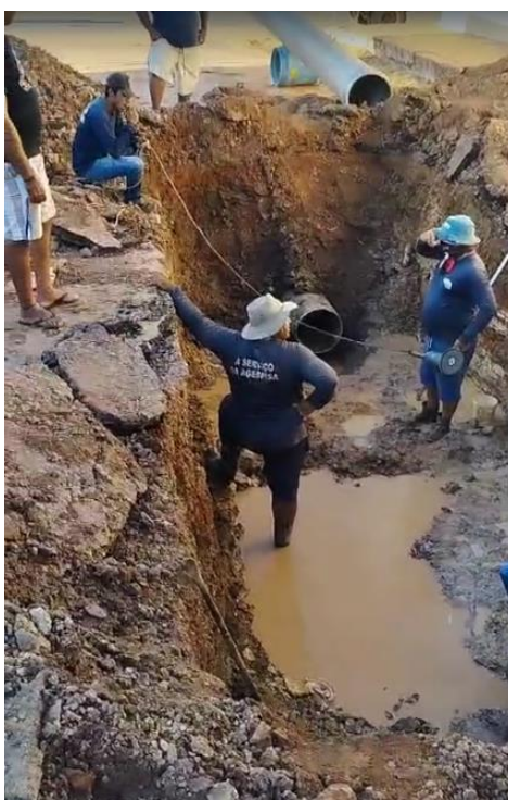
Figura 1 Manutenção da rede de abastecimento de água
